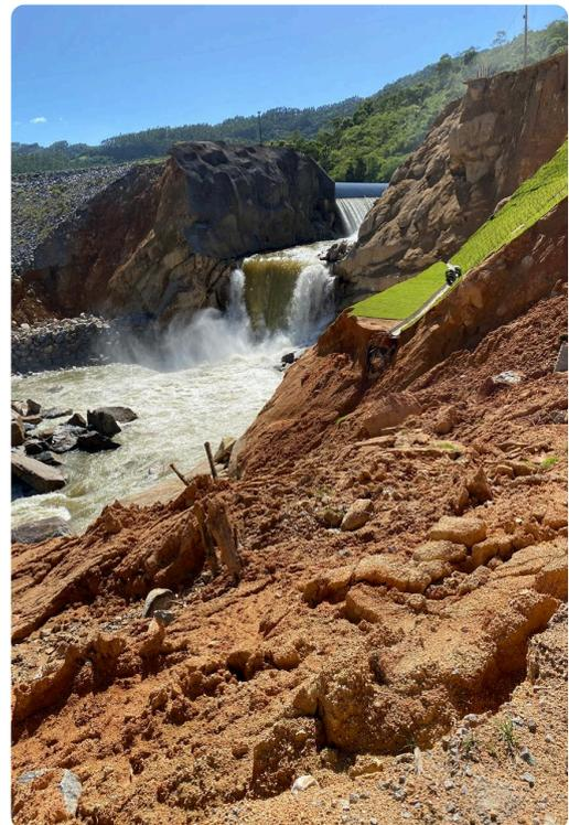
Um dos desafios mais críticos é a reconstrução do vertedouro, estrutura essencial para o escoamento controlado da água, garantindo a segurança operacional da usina e evitando futuros danos.
